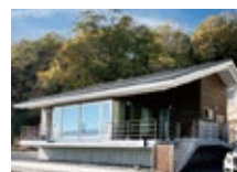
員工第一休閒中心3 (尾道市向島)
